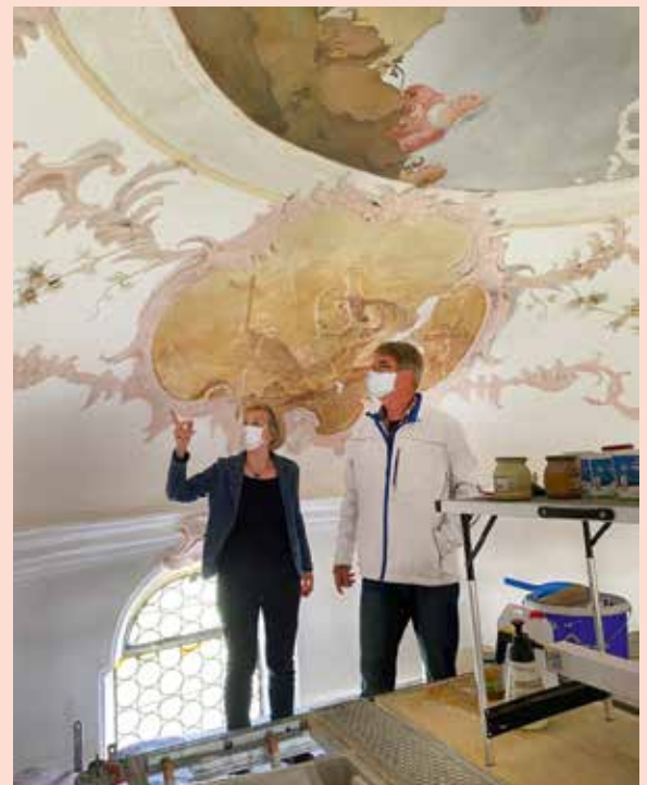
Kreisheimatpflegerin Dr. Heide Weißhaar-Kiem begutachtet mit Dipl.-Rest. Bertram Streicher auf dem Gerüst in der Rotunde die Konservierungsarbeiten in der Holzkapelle bei Beuerbach.
