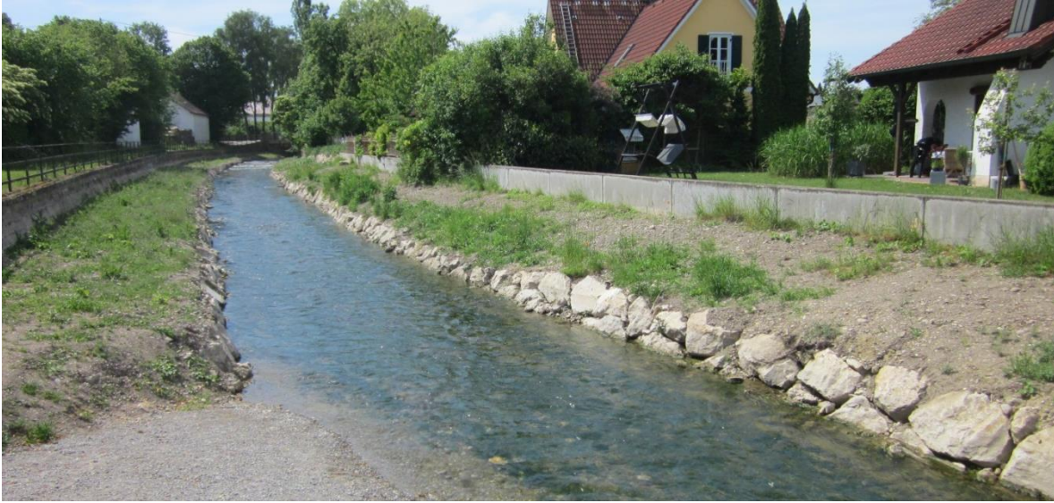
Abbildung 2: Die im Winter 2007 / 2008 errichtete Hochwasserschutzmauer am orographisch linken Ufer (im Bild rechts) (Quelle: WWA WM)
